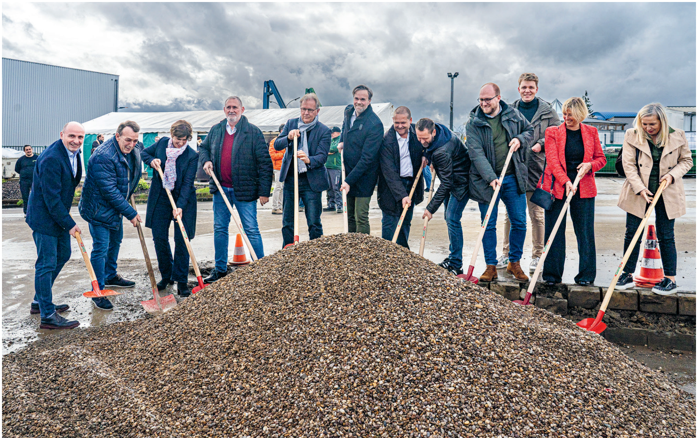
Offizielle Spuedestéch fir de Bau vum neie Ressourcen-Center vum SICA, a Präsenz vun de Verrieder vun de 7 Mengersgemengen. Et gouf, wéi ee gesäit, schwéier geschéppt!
